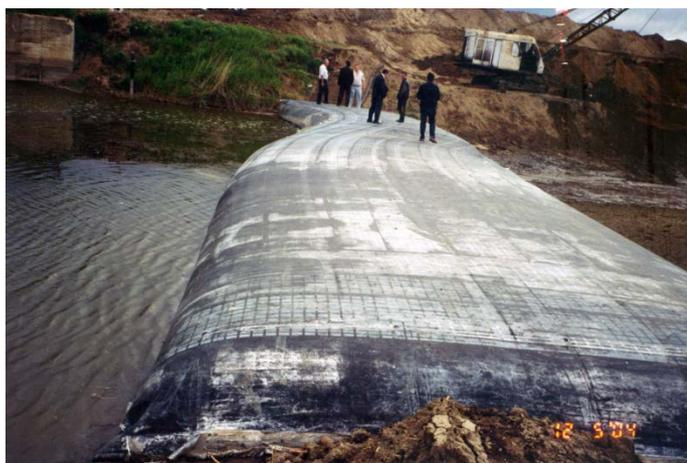
Рис. 3. Быстровозводимая гибкая дамба с высотой 3,0 м, перекрывающая канал Варнавинского водохранилища
