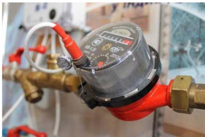
Рис. 3. Перетворювачі витрати – ПРГ для установки на трубопроводі гарячого водопостачання
