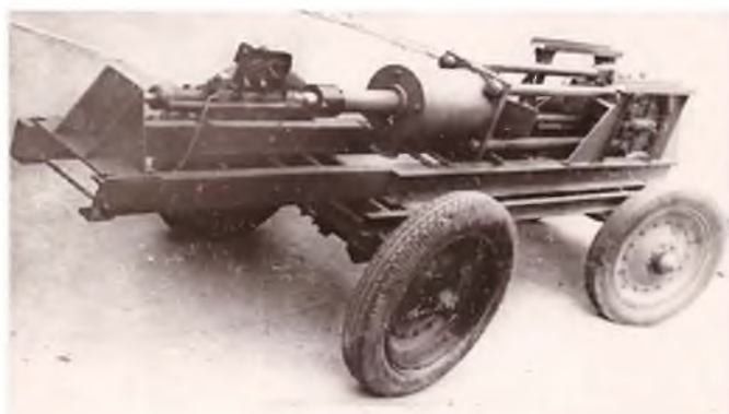
Рис. 1 – Опытно-производственный копер порохового действия типа ВК-7 на транспортной тележке
