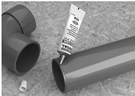
Рисунок 2.23 – Процес склеювання труб
