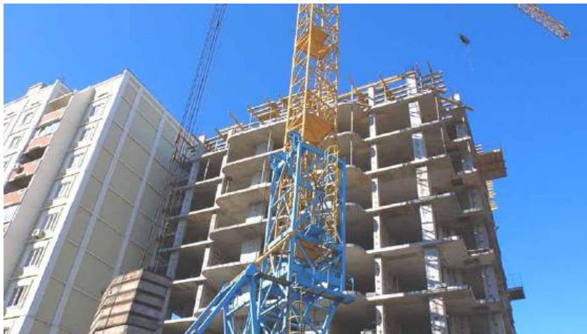
Рисунок 9.17– Сучасні технології будівництва
