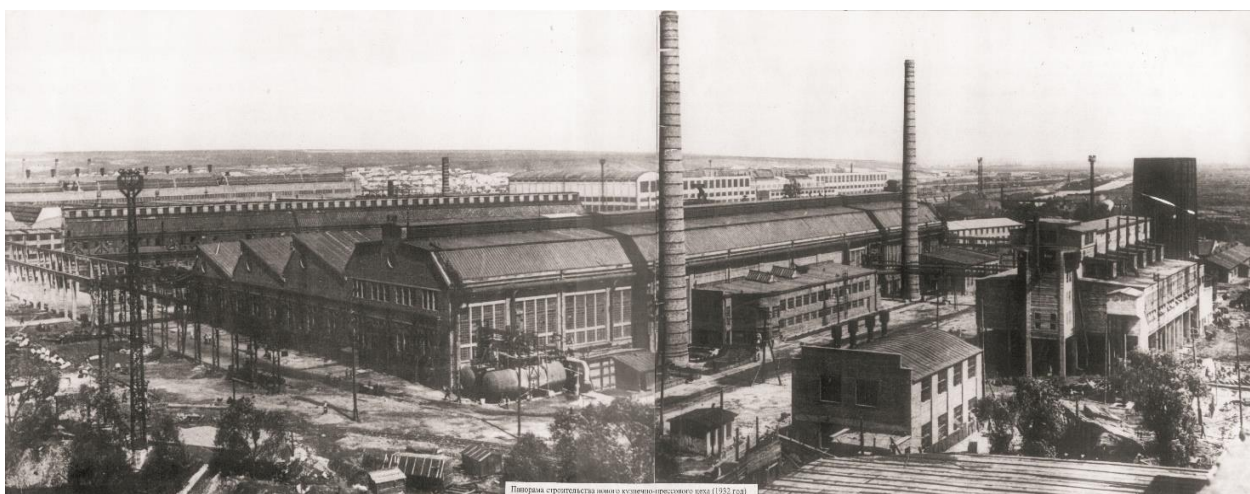
Панорама строительства нового кузнечнопрессового цеха Ворошиловградского паровозостроительного завода (1932 г.)
